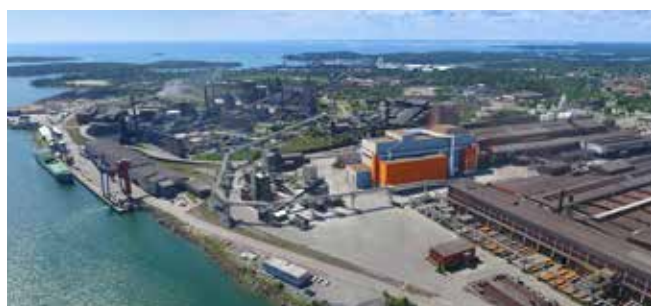
SSAB, Schweden – Übergang zur Elektrostahlerzeugung
