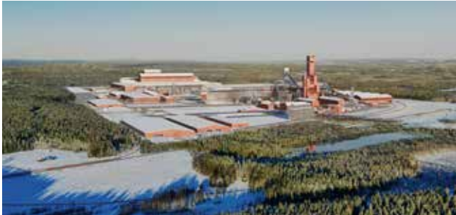
Stegna, Schweden – das weltweit erste Stahlwerk, das zu 100 Prozent mit Wasserstoff betrieben wird
