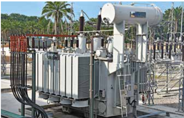
Einer von zwei Abspanntransformatoren 132/33kV, Nennleistung 150 MVA mit primärseitigem Stufensteller zur Spannungsregelung auf der Sekundärseite. Die Beschaffung der Transformatoren erfolgte durch die SMS group China.
