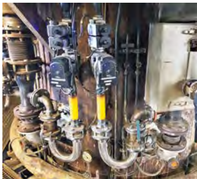
Gaszuleitung mit neuen Regel- und Abschalbaugruppen.
