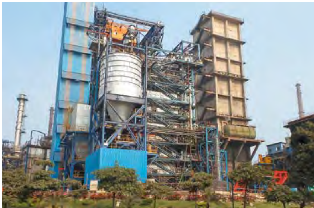
Neue Kokstrockenkühlanlage bei Tata Steel, Jamshedpur, Indien.
