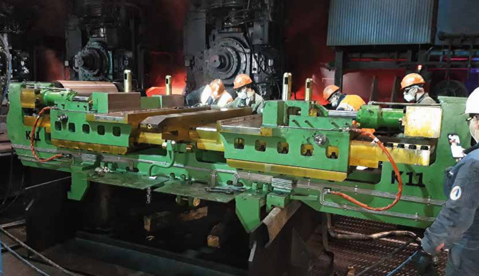
Während der Vormontage und der Funktionstests der neuen Einrichtungen bei laufender Produktion wurde ein Dummy-Zwischengerüst-Gestell eingesetzt. Dabei kam auch der eigene neue Hydraulik-Ventilstand zum Einsatz.
