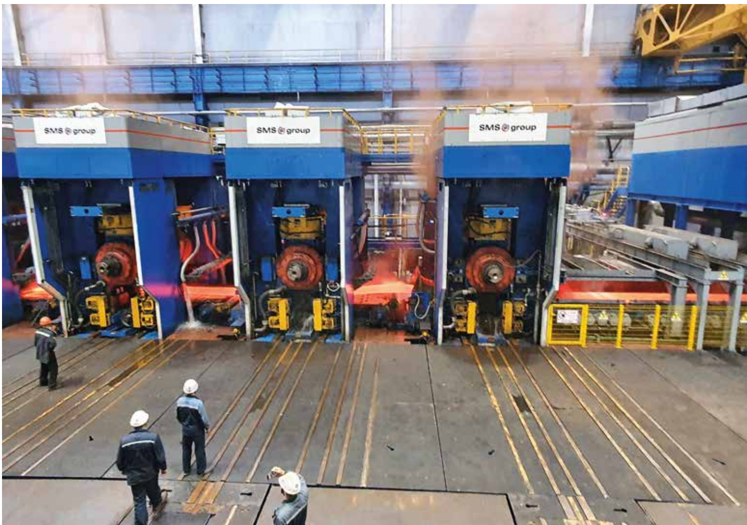
Die Fertigstraße nach dem Umbau.
