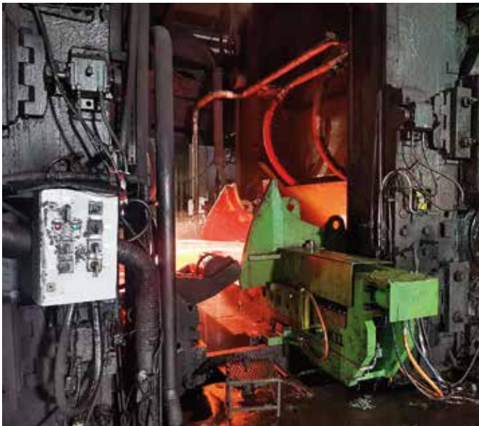
Fertigstraßenführung nach erfolgreicher Inbetriebnahme.
