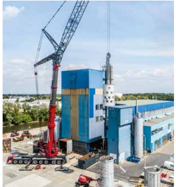
Der neue Kathodenschachtofen wird eingebaut.
