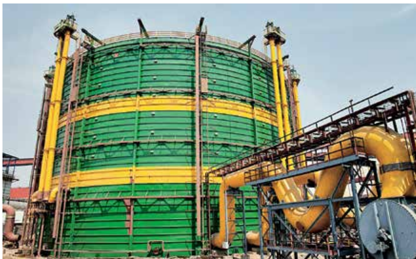
Газгольдер конвертерного газа – компетенция SMS group в технологиях защиты окружающей среды.
