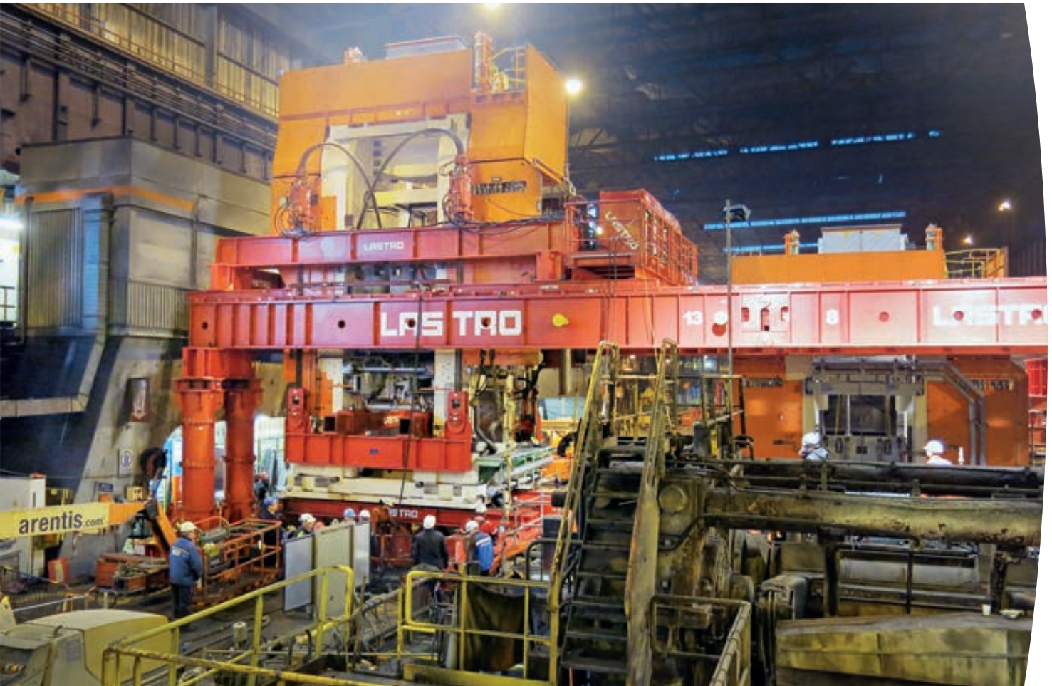
Shifting F1 into position.
