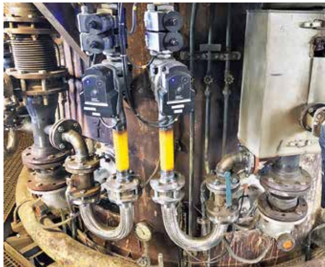
Подводящий газопровод с новыми узлами регулирования и отключения.
