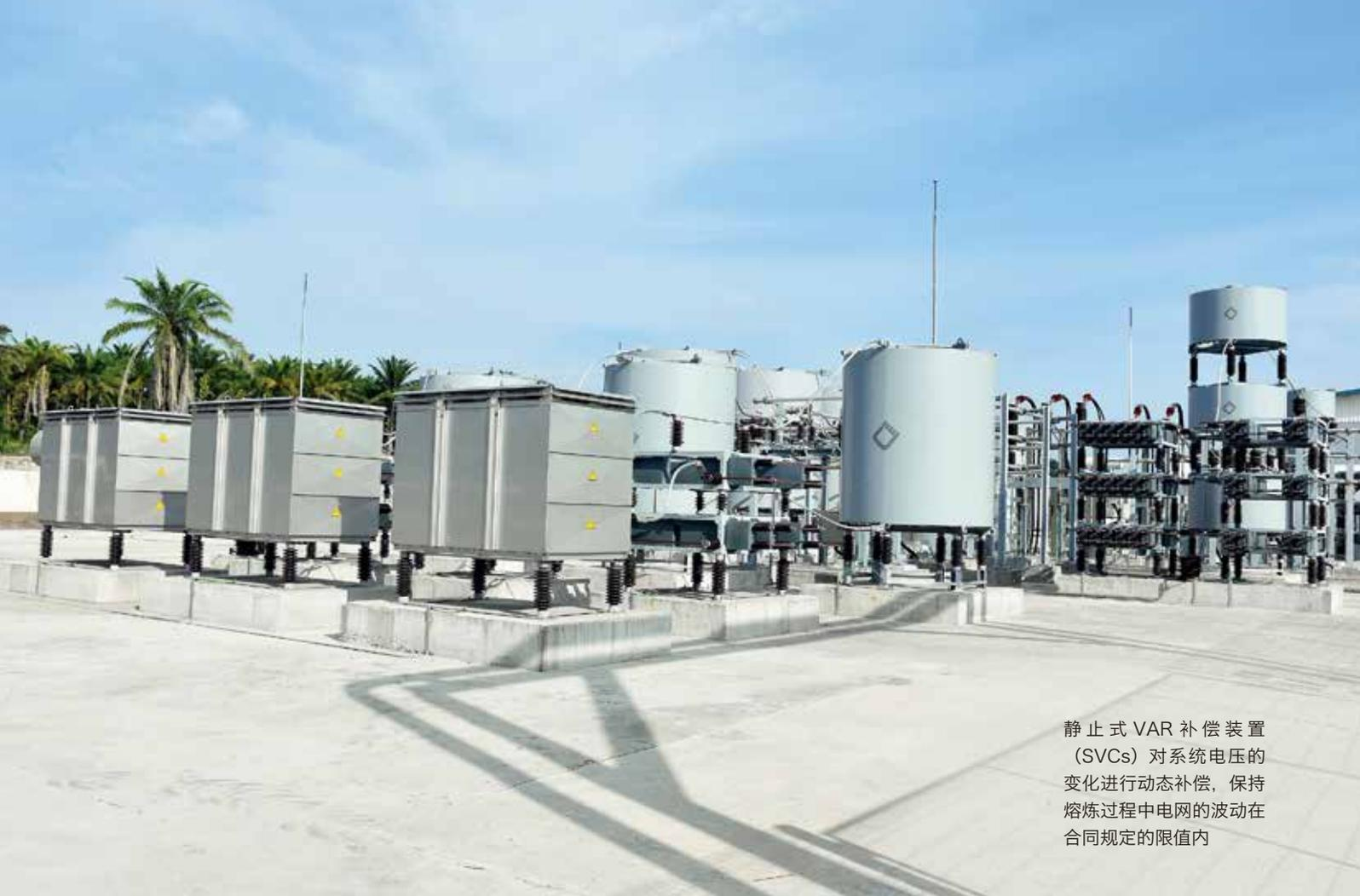
静止式 VAR 补偿装置 (SVCs) 对系统电压的变化进行动态补偿, 保持熔炼过程中电网的波动在合同规定的限值内
