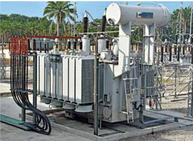
两台额定容量150MVA，132/33KV降压变压器中的一台，带原边调压分接开关以调节副边的电压。变压器由西马克集团中国公司采购
