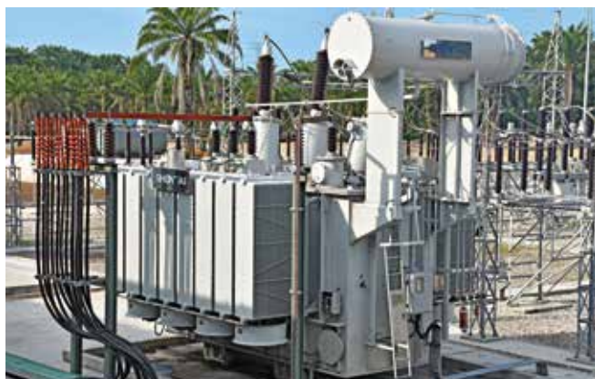
Один из двух понижающих трансформаторов 132/33 кВ номинальной мощностью 150 MVA со ступенчатым регулятором в первом контуре для регулирования напряжения во втором контуре. Закупкой трансформаторов занималась компания SMS group China.
