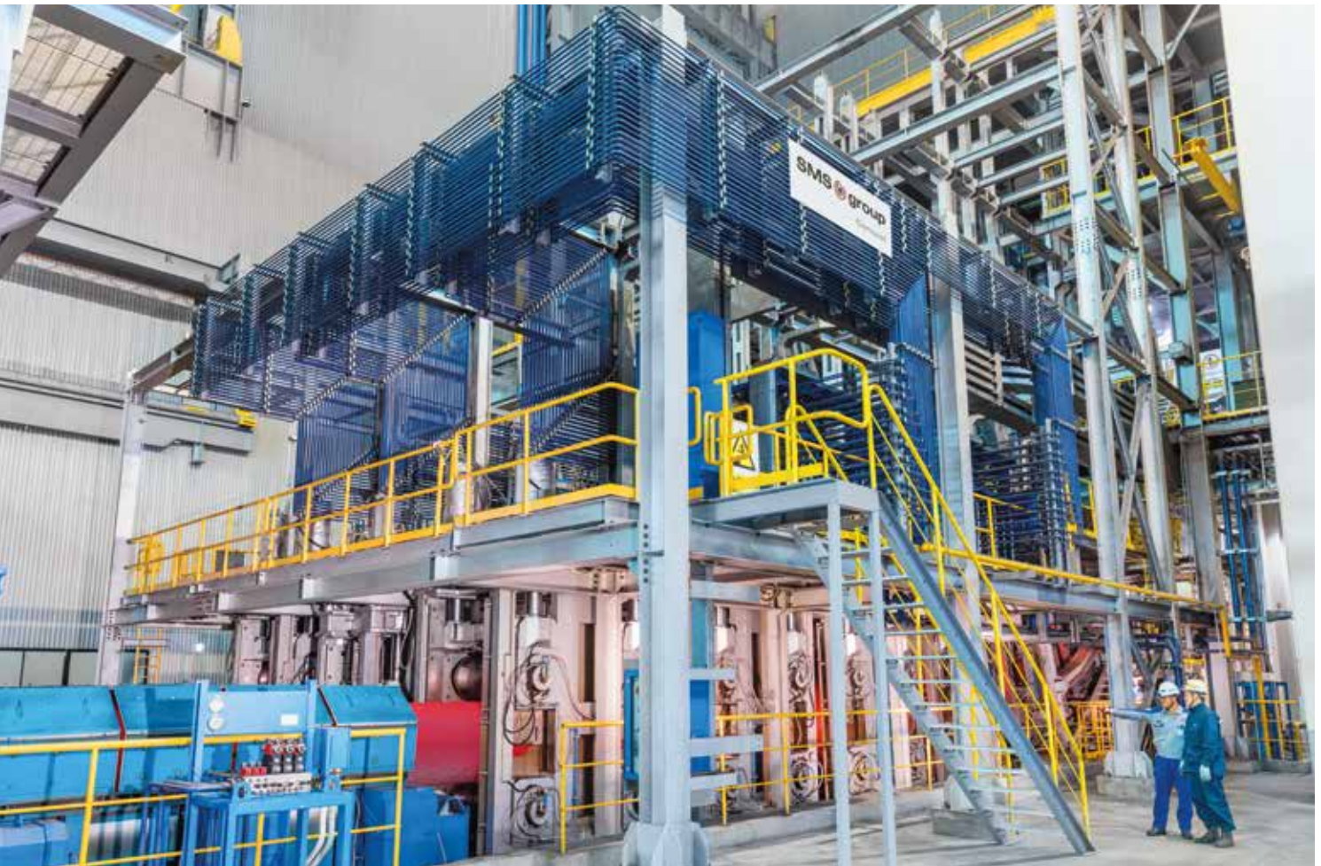
TAEWOONG gießt in Südkorea erfolgreich 1.000-Millimeter-Rund-Vorblöcke auf der Stranggießmaschine von SMS Concast.
