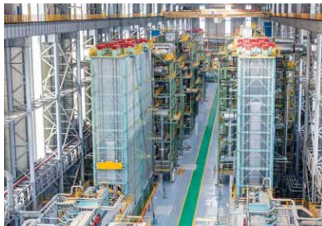
Die Linien sind Teil des neuen Flachstahlkomplexes, den die SMS group in der Provinz Shandong an der chinesischen Ostküste errichtet hat.
