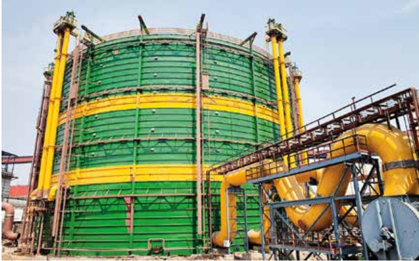
Gasspeicher für Konvertergase – Kompetenz der SMS group in Umwelttechnik.
