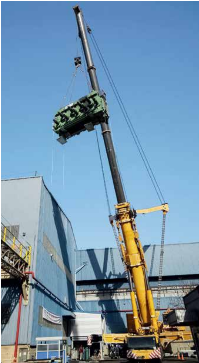
韩国现代钢铁安装新的水平矫直机
