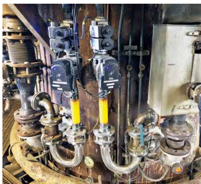
采用新的控制和切断总成的供气管路
