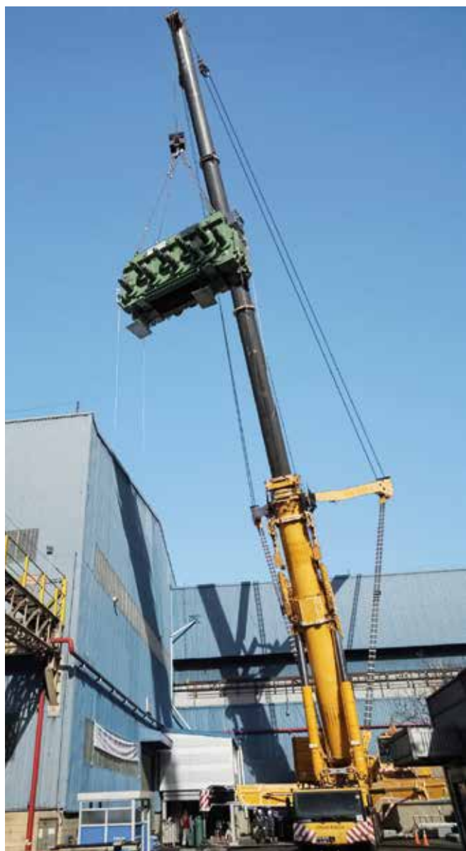
Работы по монтажу новой горизонтальной правильной машины на корейском предприятии Hyundai Steel.
